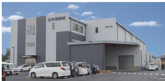
日本通信紙（株）印西BPOセンター
